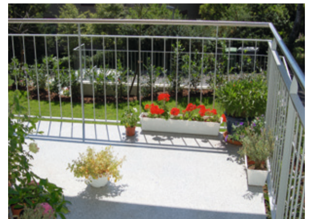
Das trittschalldämmende 2-K-System StoPur EB 200 reduziert die Geräuschbelastung stark genutzter Aussenräume.
