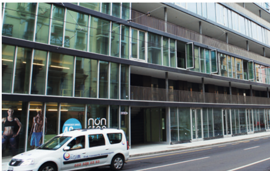
Diese Laubengänge an einem Neubau in Genf wurden vollflächig fugenlos mit StoSilent Direct belegt.
